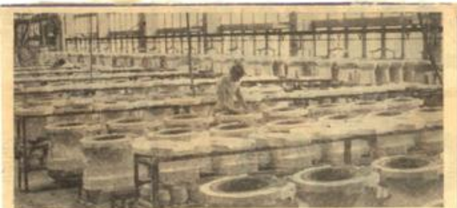
Opłety widok hali produkcyjnej.
