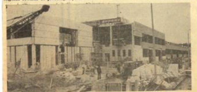
Montaż obiektów zakładu nr 2 został już niemal całkowicie zakończony.
