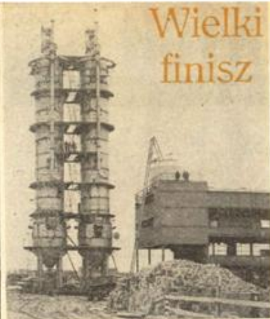
Debieląją kadeba roboty instalacyjne.
